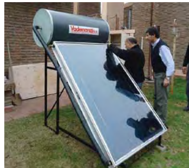
Instalación de calefón solar en Hogar de Ancianos, Cañada Rosquín, Región 4
