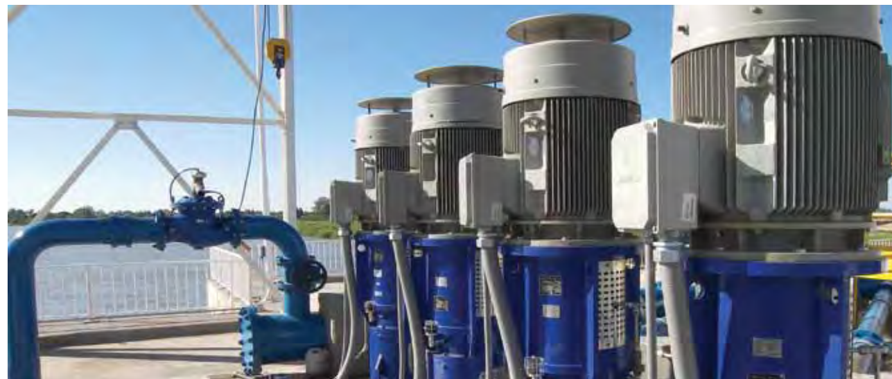
Estación de bombeo, Acueducto Centro Oeste, Toma Monje
