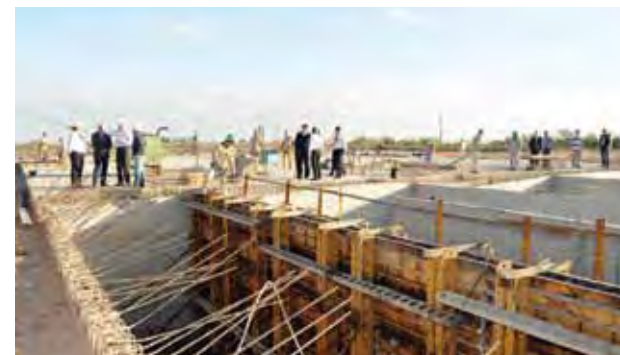
Obra acueducto Desvío Arijón
