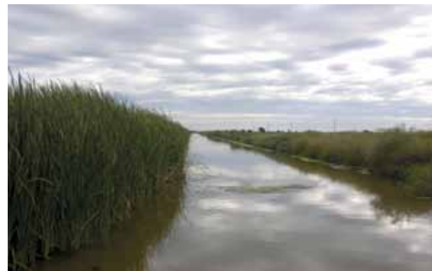
Azud nivelador Tostado
