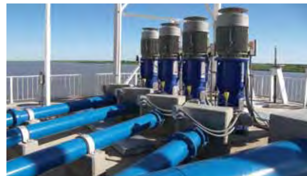
Acueducto Centro Oeste Santafesino, Toma Monje
