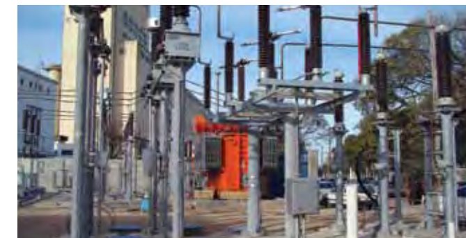
Estación transformadora Puerto Santa Fe
