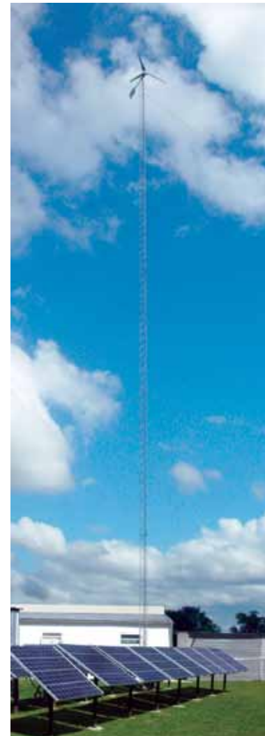
Instalación de sistemas de energías renovables en Escuela Primaria N° 1312. Isla Guaycurú, Región 1
