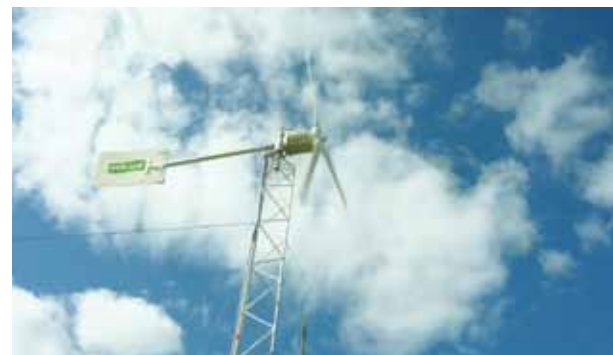
Instalación de mini-aerogenerador en Puerto Santa Fe, Región 3
