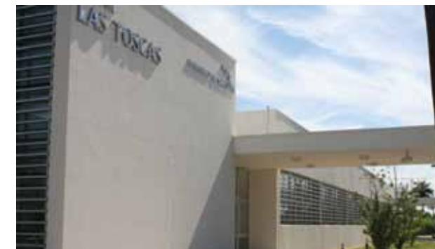
Hospital de mediana complejidad Las Toscas
