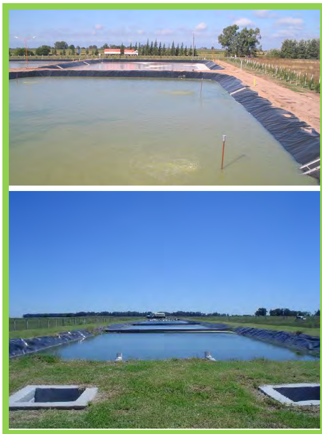
. Lagunas de tratamiento cloacal con el diseño correcto.
