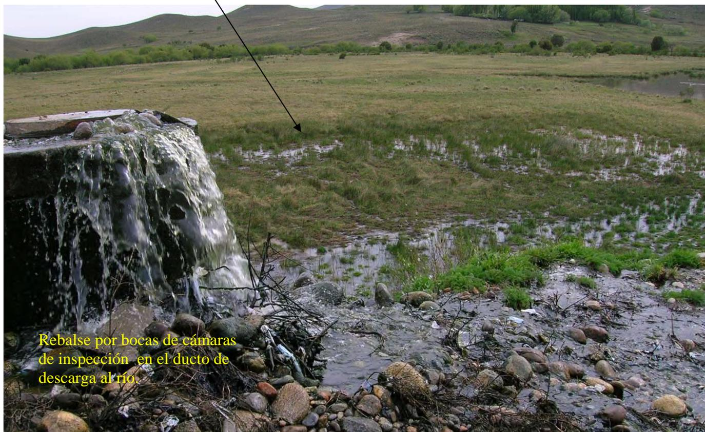
Rebalse por bocas de cámaras de inspección en el ducto de descarga al río.
