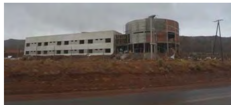
Imagen 50. Hotel en construcción en Añelo
