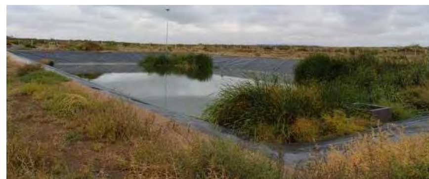
Imagen 39. Planta de tratamiento de aguas cloacales de Añelo
