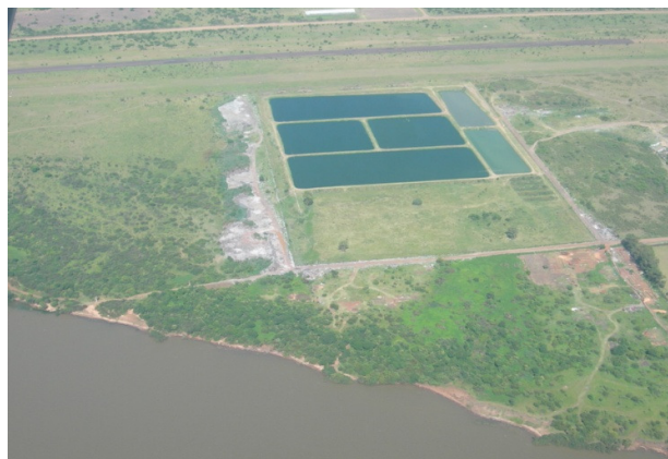
Vista aérea del área de la Planta depuradora de efluentes cloacales, basurales y sector pista aeródromo. Fuente: Relevamiento aéreo en 2008, en el marco del trabajo de campo del PDU MC
