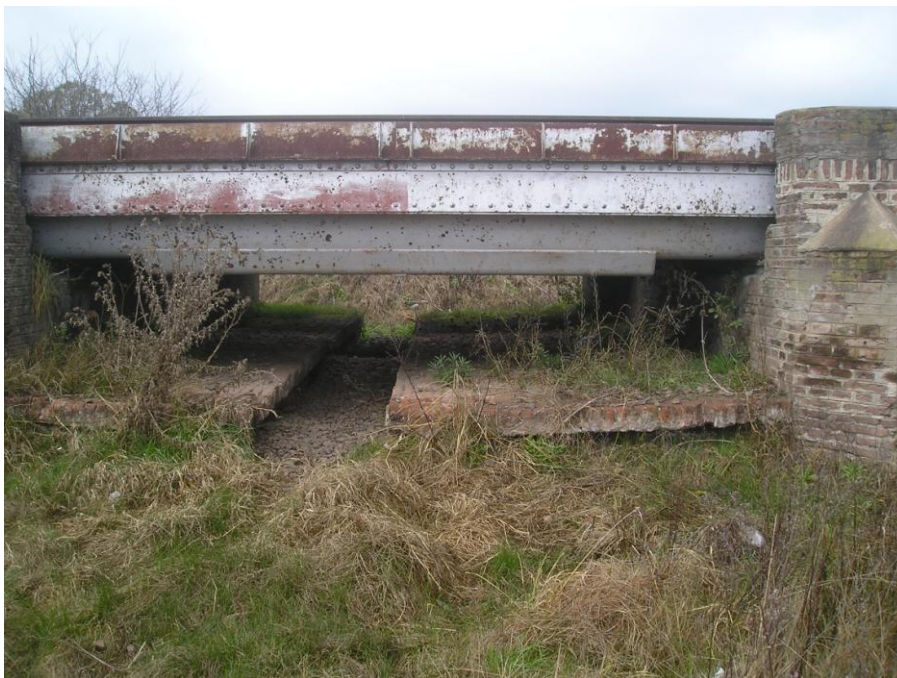
Foto 2: Vista de la alcantarilla del ferrocarril
