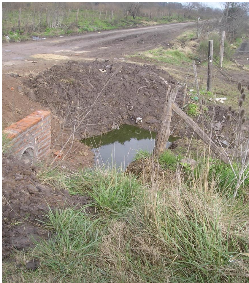
Foto 7: Imagen alcantarilla recientemente construida y acceso a propiedad
