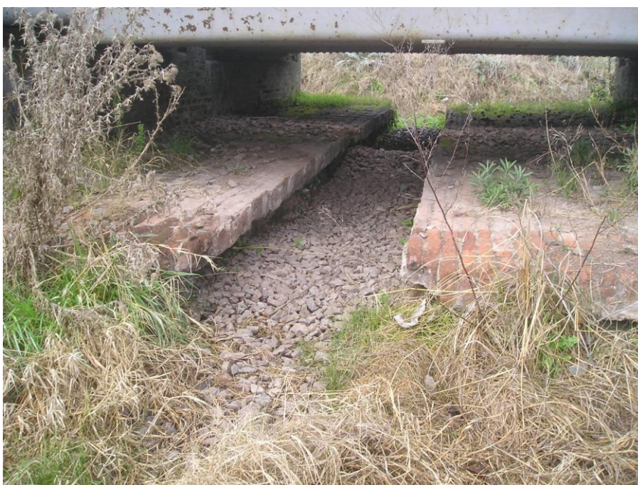
Foto 3: Vista de los trabajos realizados sobre la alcantarilla
