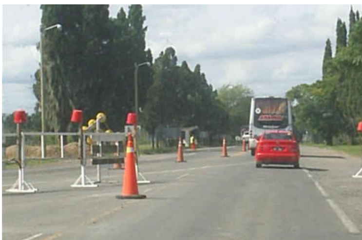
Imagen 2. Obras en el tramo Mercedes - Olivera.
