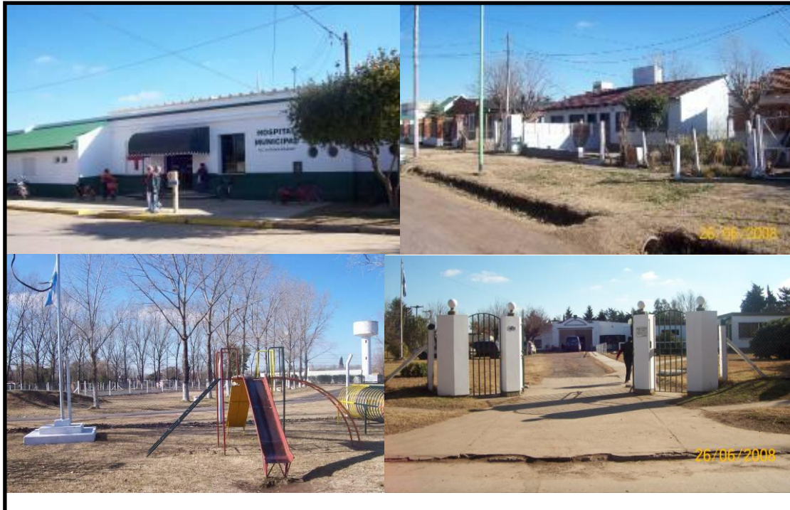
Hospital Municipal – Viviendas Municipales para Jubilados – Centro de Discapacitados Hogar Ancianos
