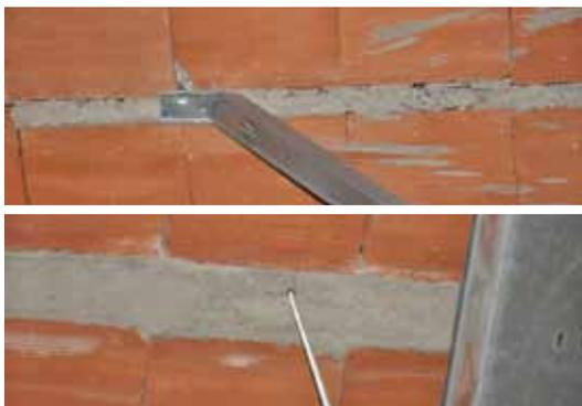
**Figura 40.** Detalle conexión diagonal de techo
