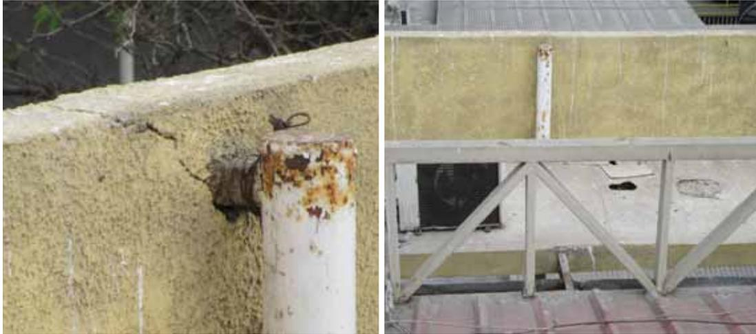
Se muestra en detalle el estado de la conexión a la estructura de soporte, la cual presenta un alto grado de oxidación. No se cuenta con información sobre el diseño de las conexiones y del sistema de soporte metálico que sostiene los equipos de aire acondicionado.
