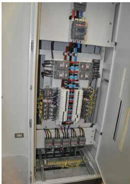
**Figura 43.** Ausencia de anclajes en equipo eléctrico
