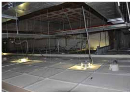
**Figura 42.** Equipo de comunicaciones sin anclaje
