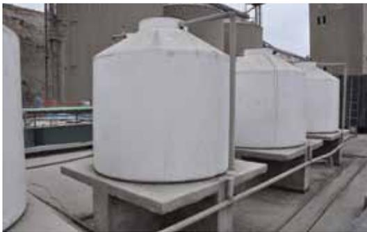
Los estanques de agua potable son de fibra de vidrio y se encuentran en el techo, simplemente apoyados sobre estructuras de hormigón armado. Se requiere implementar restricciones al desplazamiento lateral de los estanques, los cuales son sísmicamente vulnerables.
