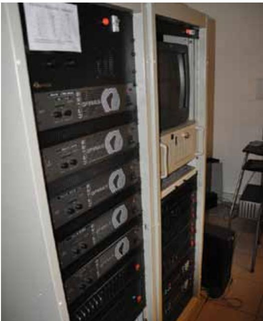
**Figura 31.** Equipo de comunicaciones sin anclaje
