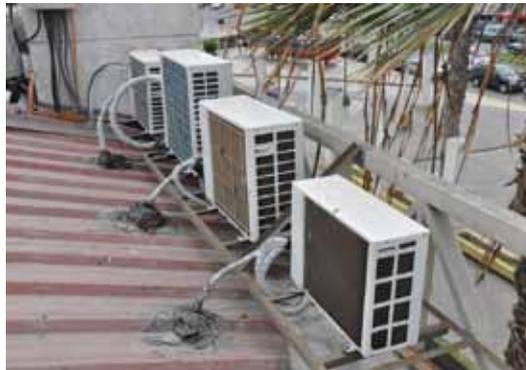
**Figura 52.** Conexión a la estructura de soporte de aire acondicionado
