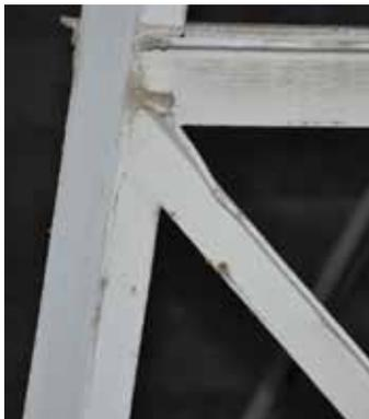
**Figura 59.** Daño en perfil de estructura de soporte correa transportadora
