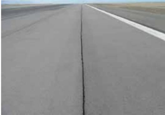
**Figura 33.** Grietas pavimento pista de aterrizaje
