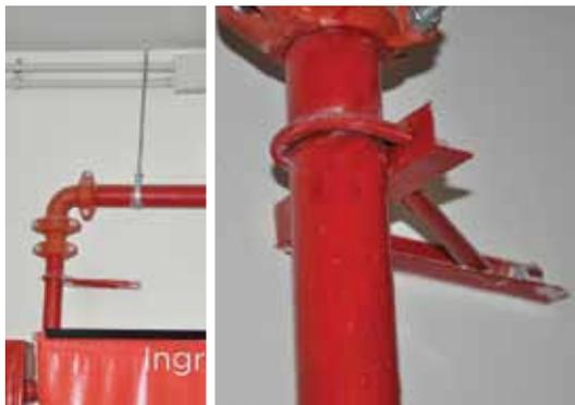
**Figura 39.** Anclaje de escalerillas y tabiquerías
