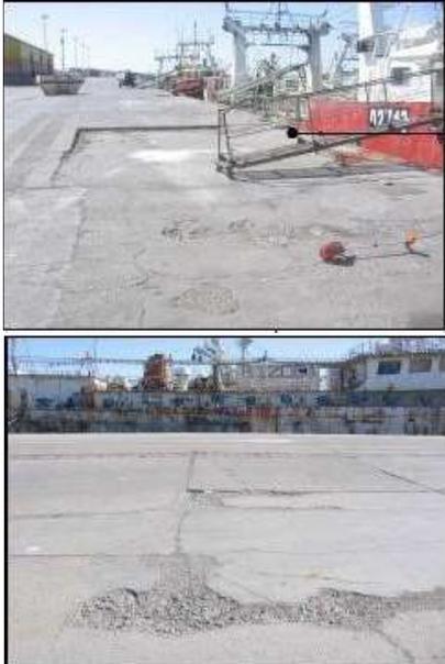
Se trata de una estructura de muelle poco convencional, dado que las losas superiores apoyan, en parte en un sistema de losas, vigas y columnas; y en otro sector se ubica sobre un sistema de bóvedas con capiteles que apoyan en pilas.
