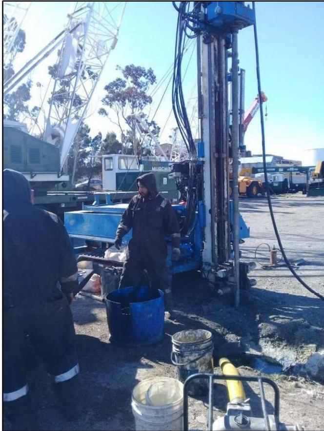
En ellos se detallan además los perfiles geotécnicos y la clasificación de los suelos en el Sistema SUCS, destacando el número de golpes **N** del ensayo de Penetración normalizado, correspondiente a los últimos 30 cm. de un segmento total de 45 cm.
