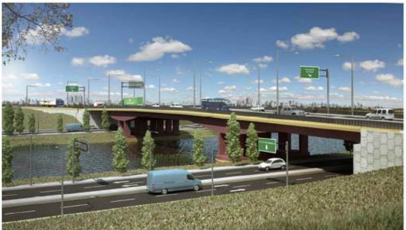
Imagen: Puente y Distribuidor conexión AU7 - Lanús.
