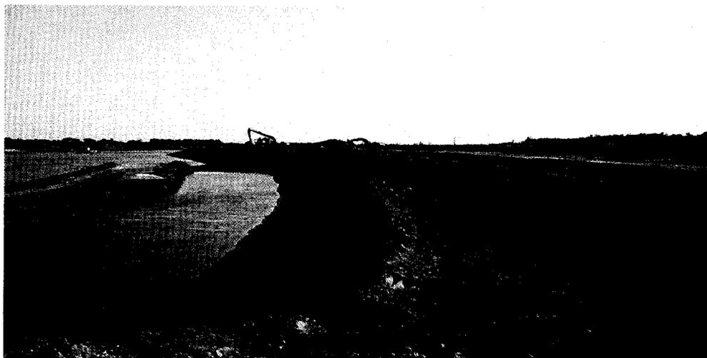
**Excavación de taludes con retroexcavadora de brazo largo y dragado del cauce –Rio Saldo –Tramo III – Sector 1.**
