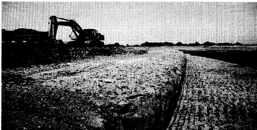
*Excavación y perfilado de talud con retroexcavadora y carga directa sobre camión volcador, Rio Salado – Tramo III – Sector 1*
