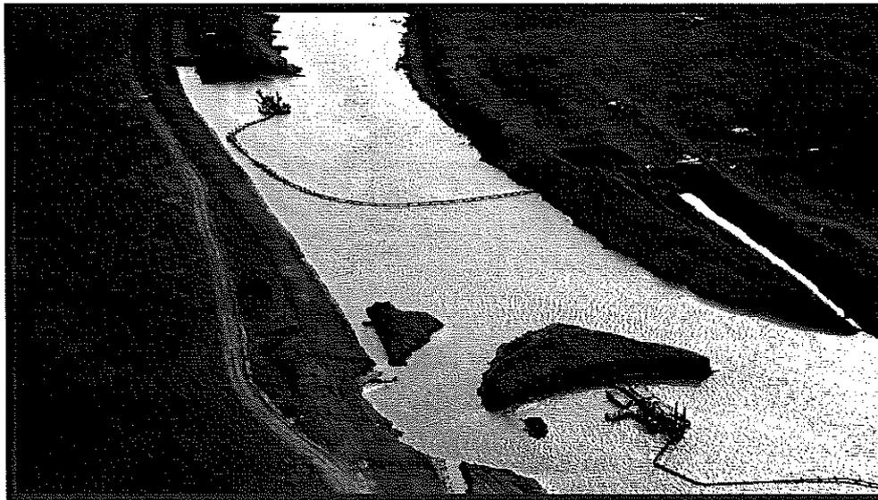
Puede observarse que fue necesario realizar, previo al dragado, la excavación, por medios convencionales, de la porción de material, correspondiente a la conformación del talud, que se encontraba por encima del pelo de agua.
